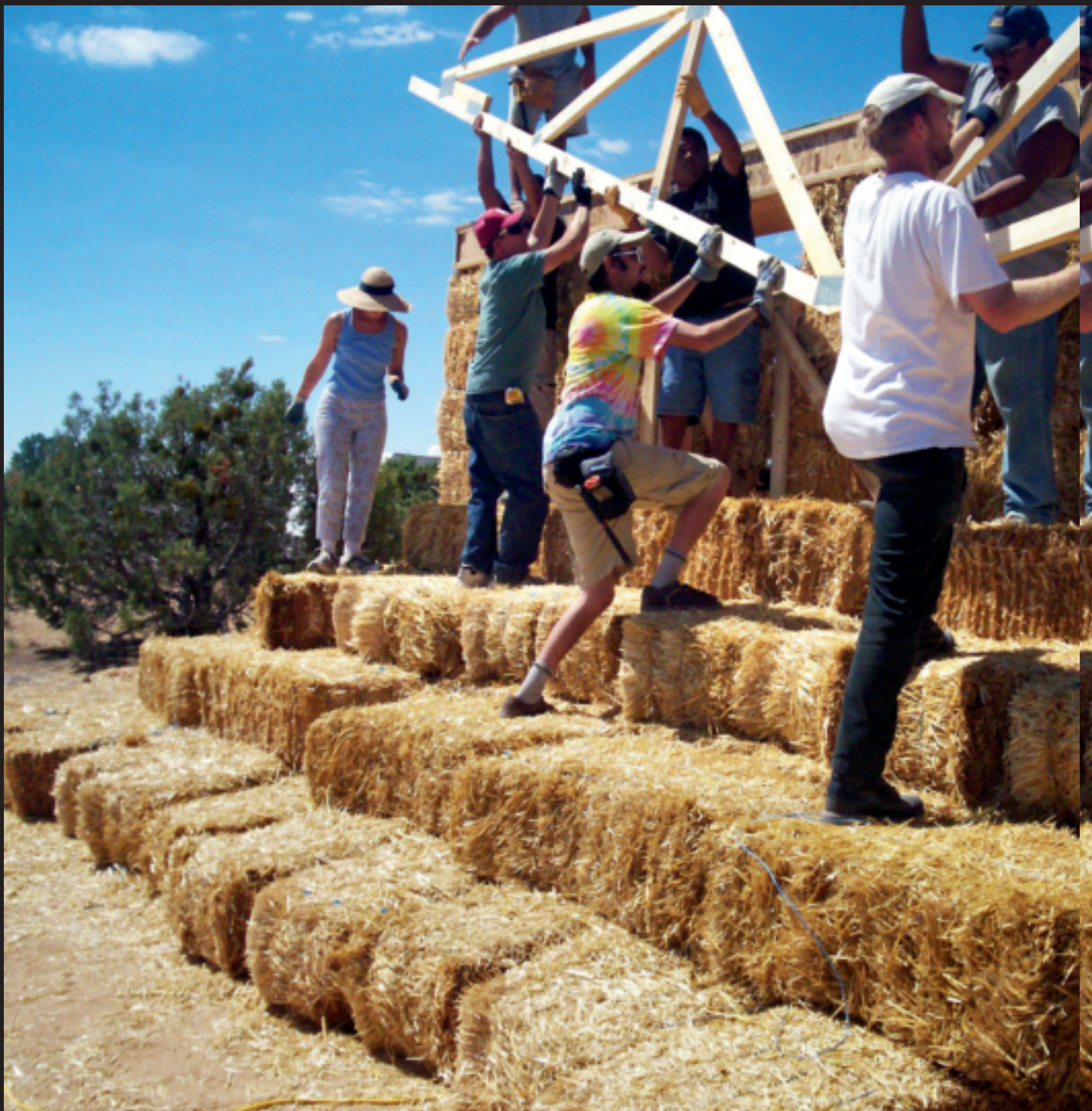
在美国,人们正在用秸秆搭建房子。打捆成型的秸秆能给木房子当墙壁,原来干枯柔韧的秸秆能辅助桁架稳固房屋的结构。秸秆在高强度挤压后非常紧致,是一道很好的隔热保温层。来源:ORIO architecten
