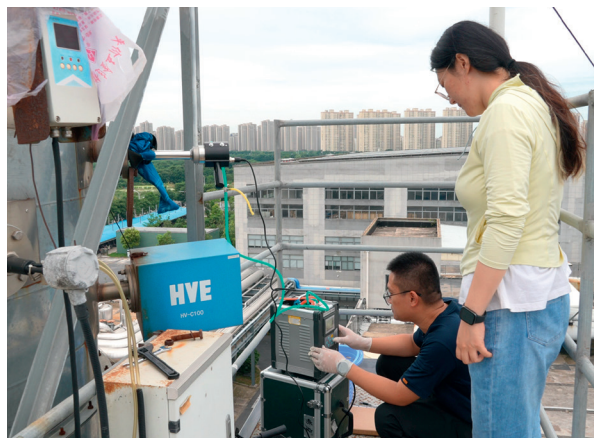
帮扶人员不惧高温“烤”验,爬上数十米的高空监测平台,对废气排放进行监测记录
