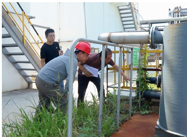
帮扶人员现场对企业废水站房取水管和排水管进行检查
